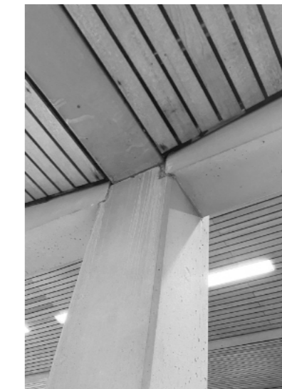
Trägeranschluss Stütze zwischen den Schwimmhallen
