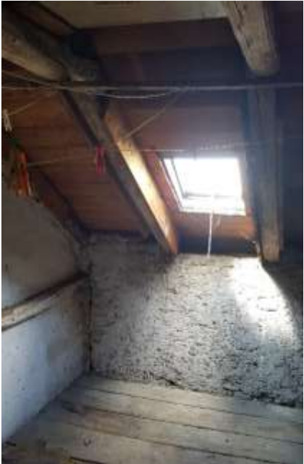
Nordseite Achse Abstellraum/ Raum 8
