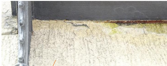
Korrosion am Balkon
