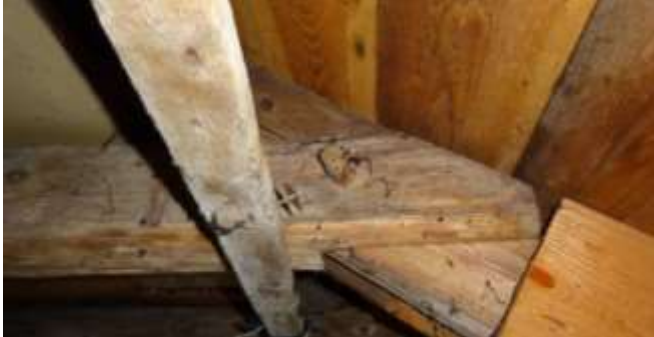
Der Kehlbalken ist ausgeklinkt und wird mit einem Holznagel am Sparren befestigt.
