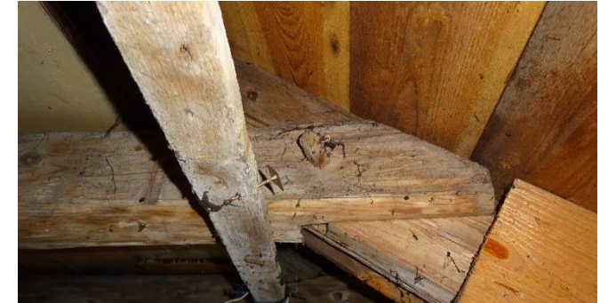
Der Kehlbalken ist ausgeklinkt und wird mit einem Holznagel am Sparren befestigt.
