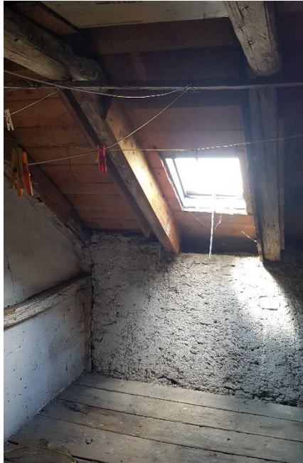
Nordseite Achse Abstellraum/ Raum 8
