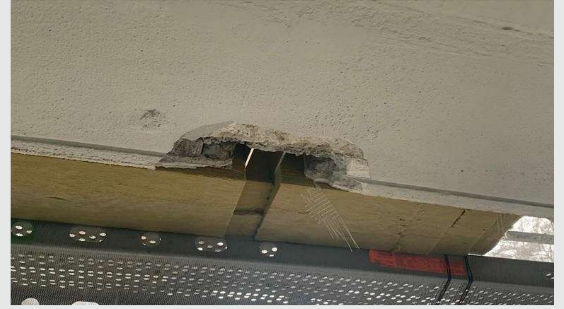
Detail: Gebäudevorsprung 1.OG zu EG Putzabschluss
