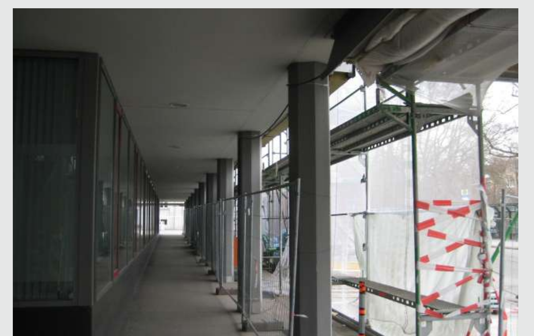
Detail: Gebäudevorsprung West - Pfostenriegelfassade + Stützensgang
