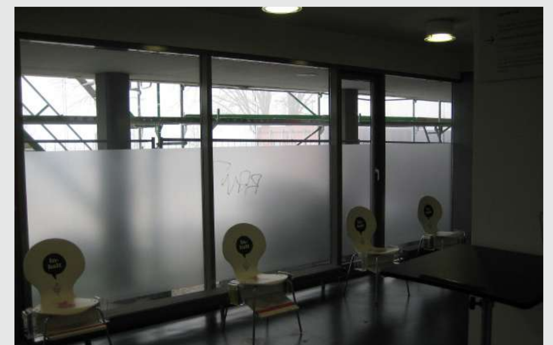
Detail: Pfostenriegelfassade - Wartebereich Bürgerbüro
