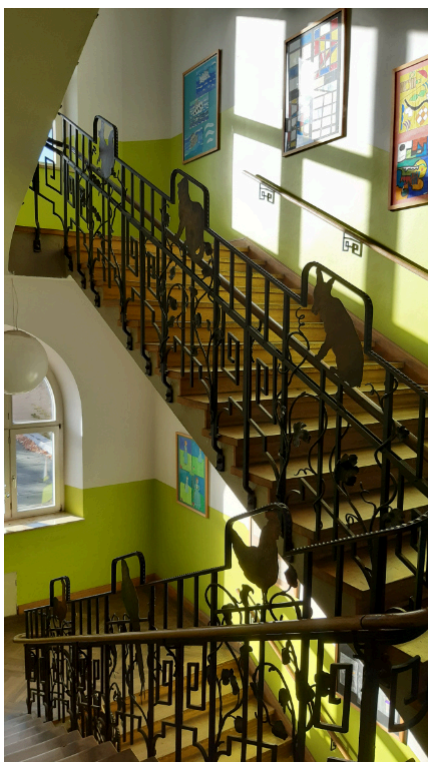
Treppenhaus mit erhaltenswertem Jugendstil-Geländer
