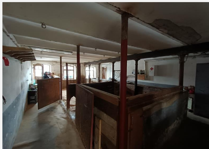
Abbildung 28: Stadel Viehstallung im Erdgeschoss
