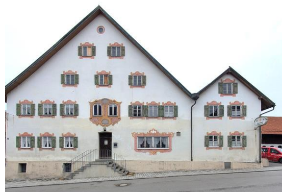
Abbildung 4: Gasthaus + Wohnhaus, Ostseite
