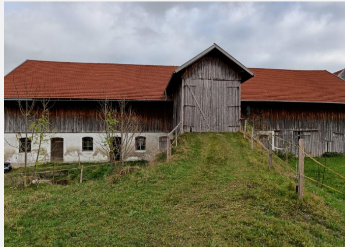
Abbildung 25: Stadel mit Hocheinfahrt, Westseite
