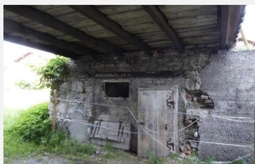
Abbildung 47: Mauerwerk unter Hocheinfahrt
