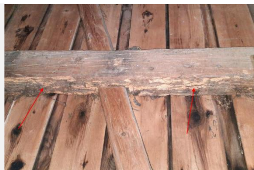
Abbildung 42: Schädlingsbefall Fachwerkwand
