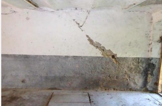
Abbildung 43: Schrägrisse
