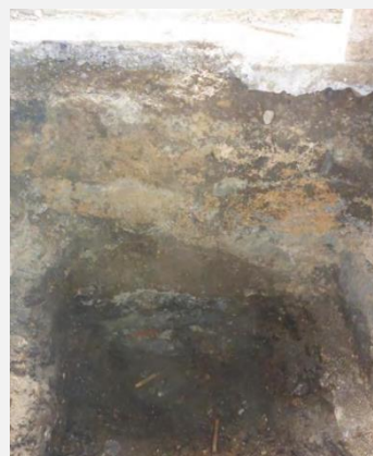
Abbildung 40: Fundamentfreilegung
