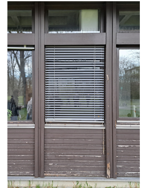
Fotografie Zustand Fassade
